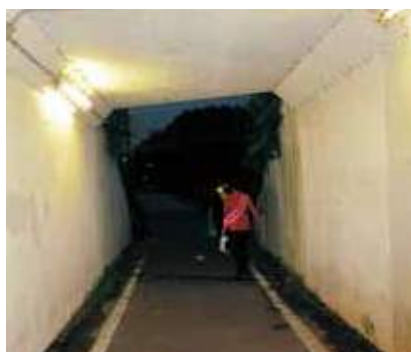
山陰本線東山公園駅付近パトロール
